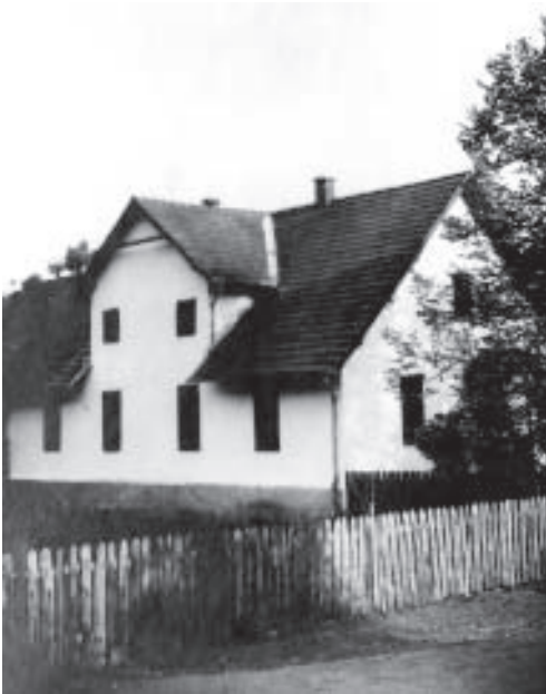
Парохијски дом у Прибинићу (изграђен 1900)
